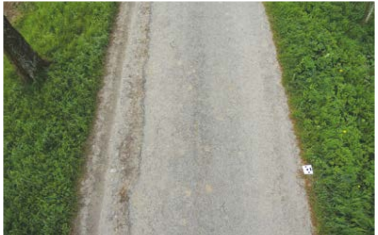
Obr. 2. Současný stav poškozeného povrchu cesty – snímek cesty s ukázkou vličovaciho bodu (foto: T. Mikita)
