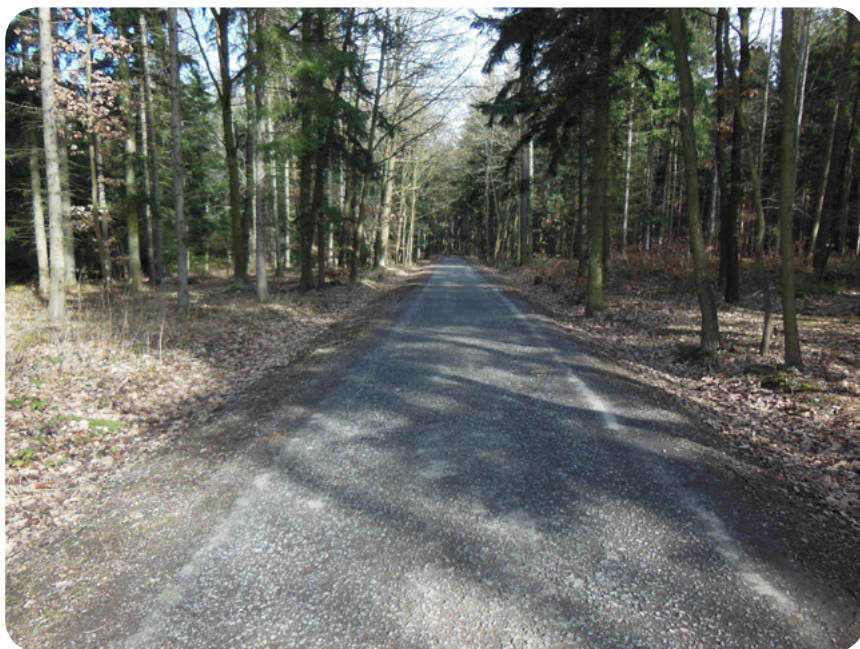
Obrázek 8.1: Lesní cesta 1(L) s povrchem z asfaltového betonu
