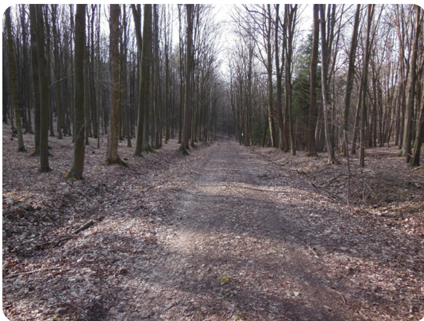
Obrázek 8.2: Lesní cesta (2L) s provozním zpevněním.
