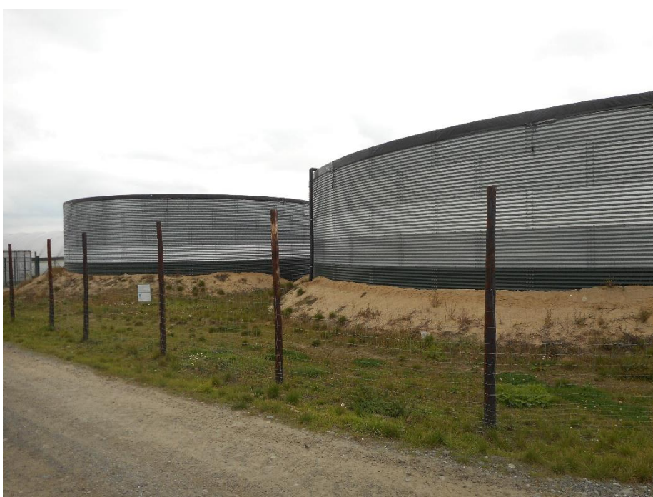
Obr. 3: Montované nádrže Buwatec, Sobětuchy, těsnění PE, objem celkem 3 000 m 3
