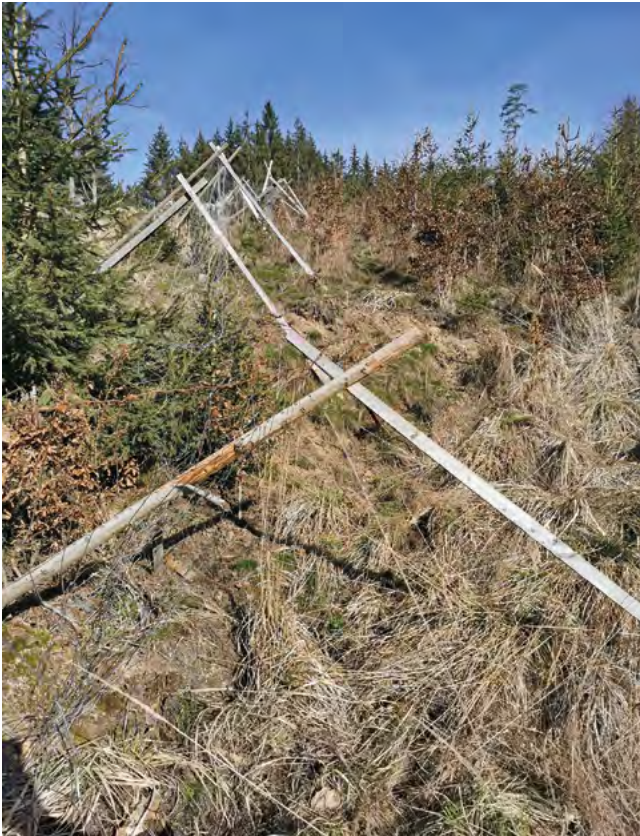
Obr. 6: Levný, ale málo funkční typ oplocení bez spodních ráhen.
