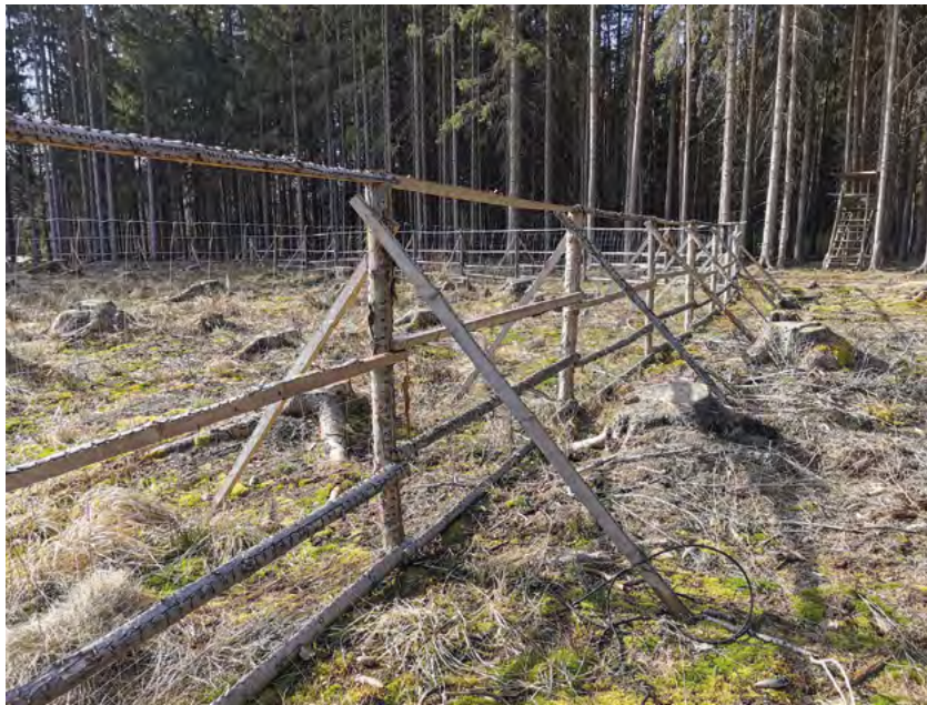
Obr. 4: Kombinované oplocení (drátěné a dřevěné). Ke stavbě byl využit materiál z harvestorových probírek. Materiál má nižší životnost, ale ta je dostačující do doby zajištění porostů.
