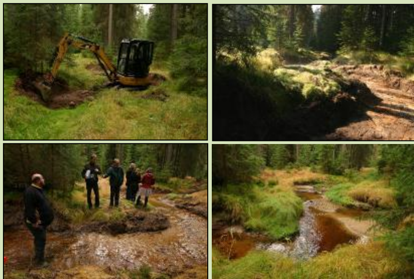
3. Vytvoření nového koryta v původní odtokové trase
