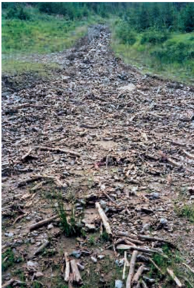
Obr. 4. Nezpevněná svážnice je značným zdrojem splavenin Unpaved slope road is a great source of sediments
