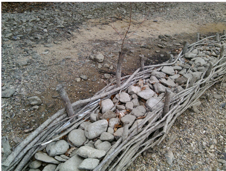
Obr. 3. Detail zápletového plůtku – nádrž Brno, oblast Osada (foto: M. Šležingr, 2013)
