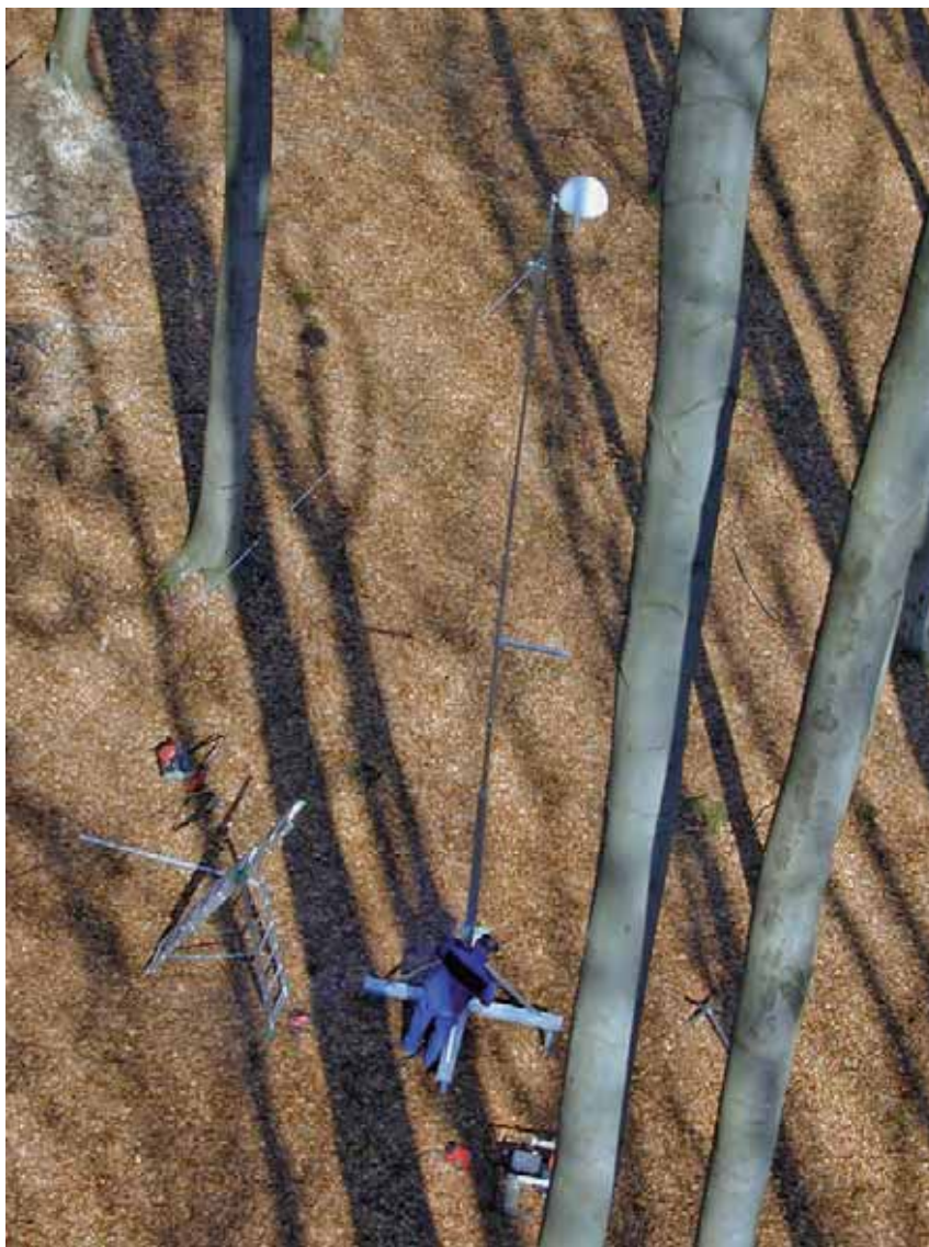
Obr. 3.13: Instalace stožáru s digitálním fotoaparátem na ploše Q 103 Všeteč / Installation of the mast with digital camera at the plot Q 103 Všeteč
