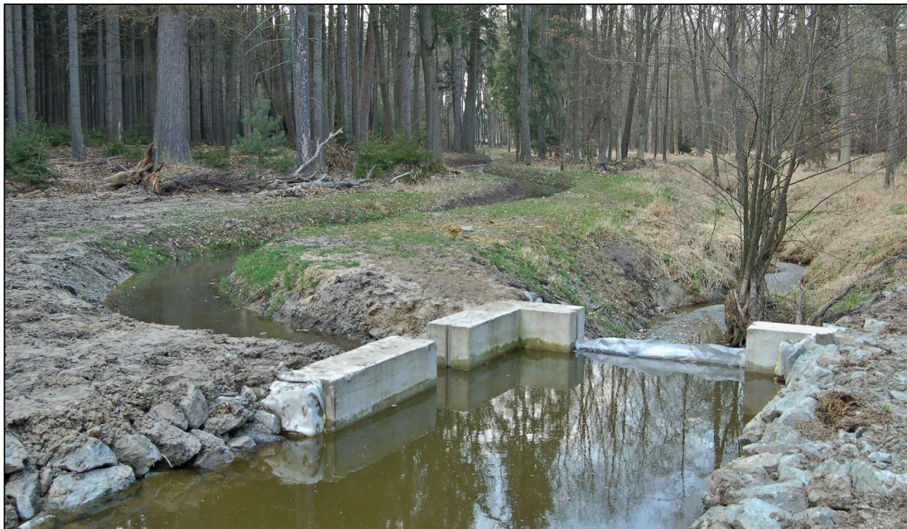
Zadržování vody v lese systémem kanálů a přehrážek, lesy na Královéhradecku, foto Jan Řezáč
