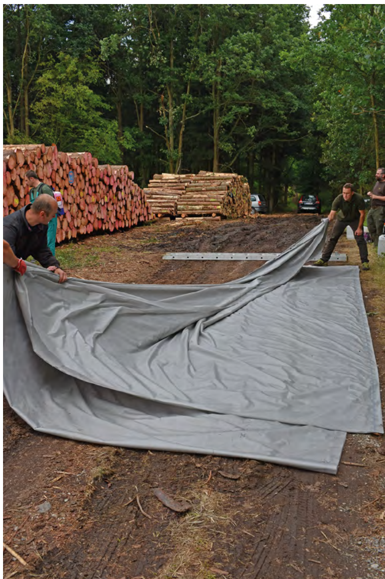
Obr. 3: Příprava na zakrytí skládky
