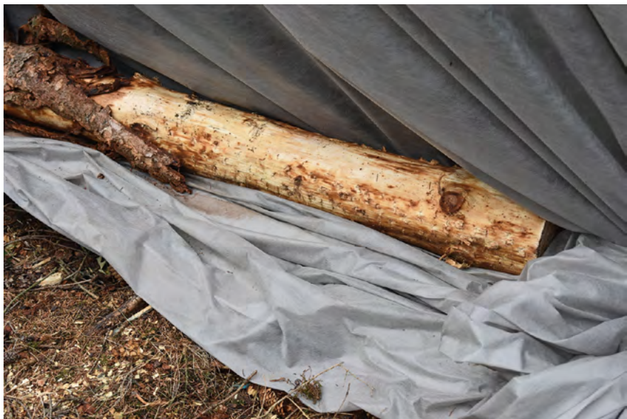
Obr. 7: Detail zatížení zakrytí skládky
