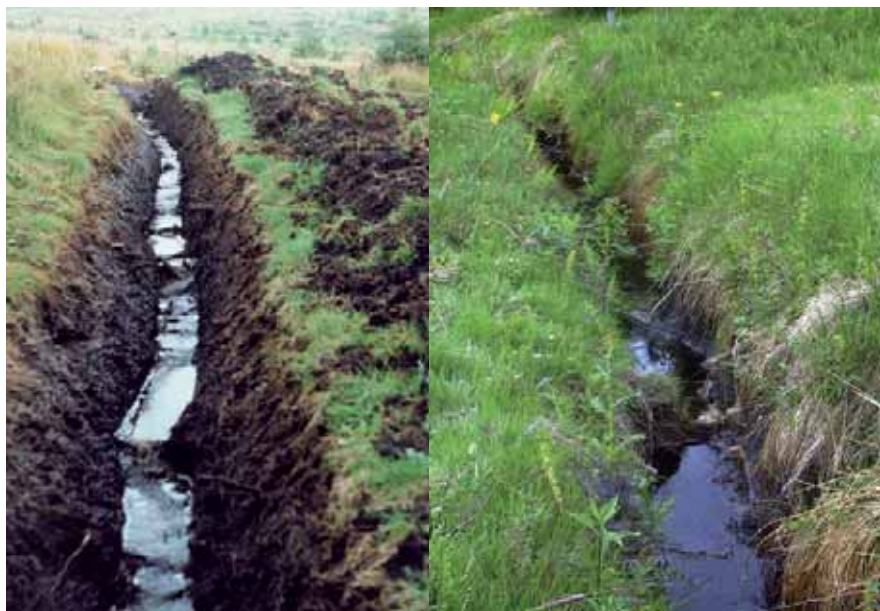
Obr. 2: Odvodňovací příkop na povodí U Dvou louček v roce 1996 a 2002 (foto: Ladislav Šorm)
