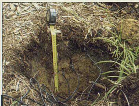
Instalace čidel. Foto: Radek Novotný
