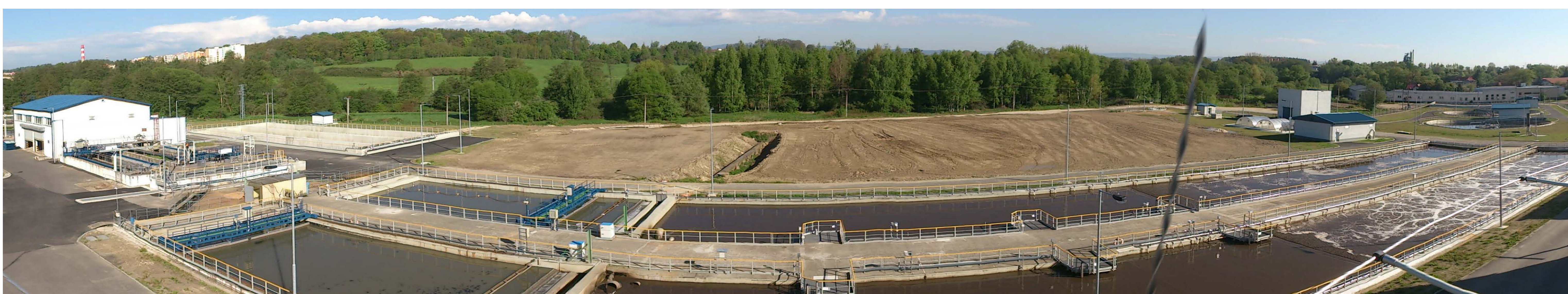
Čistírna odpadních vod v Chebu (Zdroj: Chevak Cheb, a. s.)
