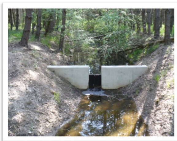
Ukázka možného křížení cestní a meliorační sítě a stabilní regulovatelné přehrážky na zadržení a retenci vody ve velmi zahloubeném hlavníku.
