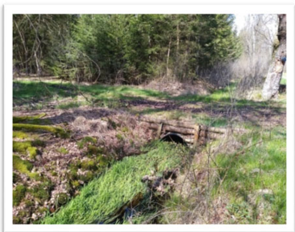
Ukázka možného křížení cestní a meliorační sítě a stabilní regulovatelné přehrážky na zadržení a retenci vody ve velmi zahloubeném hlavníku.
