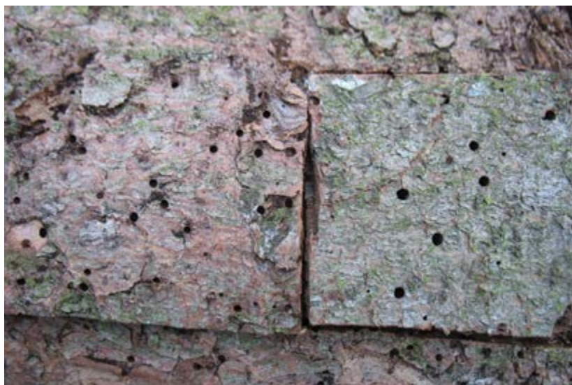
Obr. 34: Porovnání velikosti výletových otvorů lýkožrouta severského (vlevo) a l. smrkového (vpravo)
